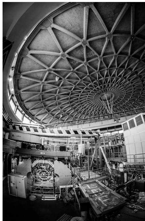
Fig. 6.1.1 DAFNE con la sua cupola in elementi pre-fabbricati(Cestelli Guidi, 1960) ed uno scorcio della macchina.
